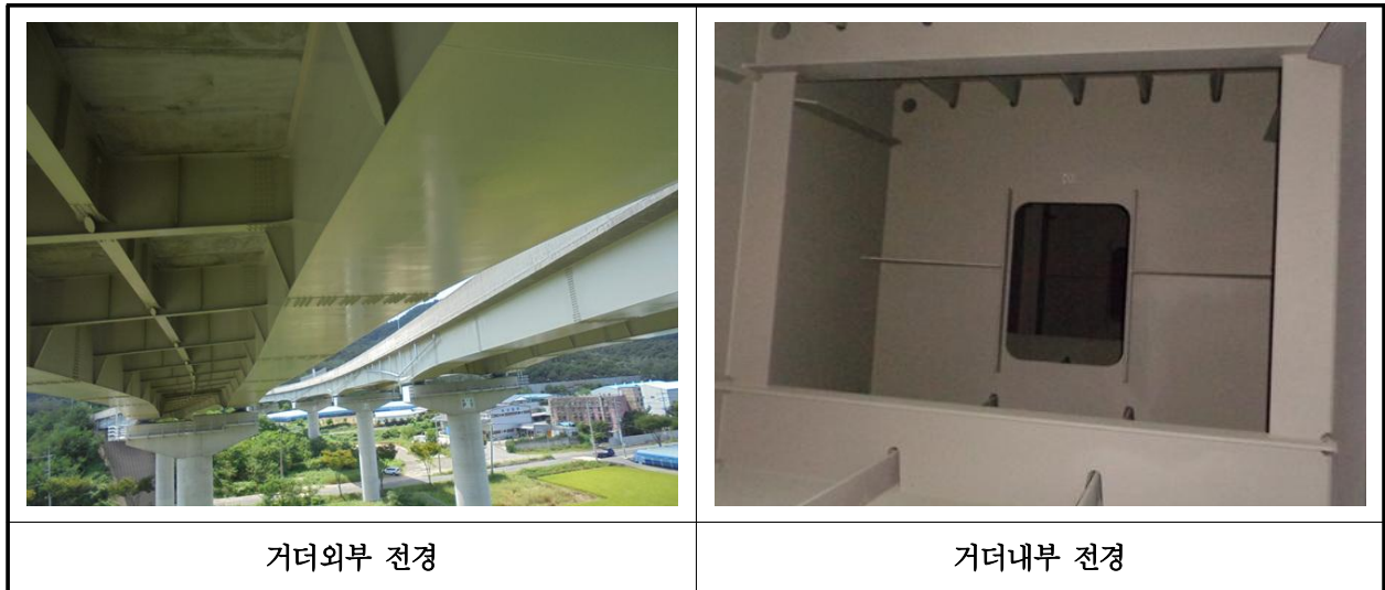
【사진 42.3.4】 거더 내·외부 전경
