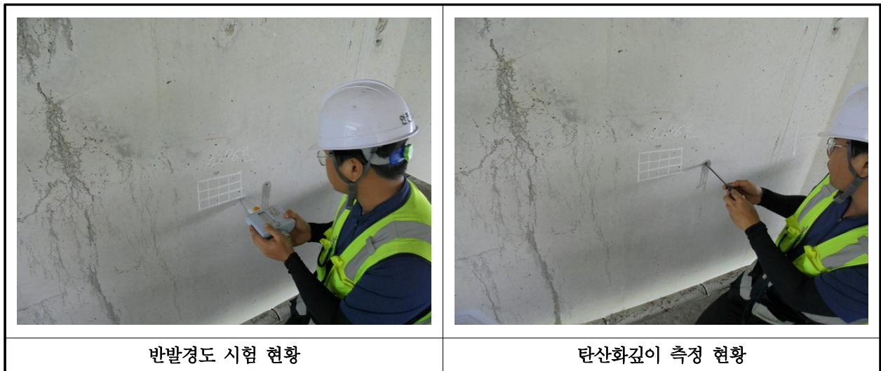
【사진 42.4.1】 콘크리트 내구성조사 현황
