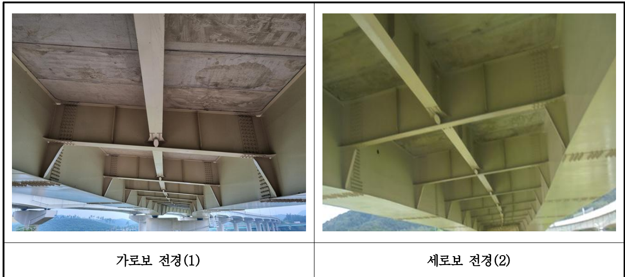
【사진 42.3.6】 가로보 및 세로보 전경
