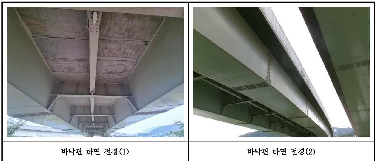
【사진 42.3.2】 바닥판하면 전경
