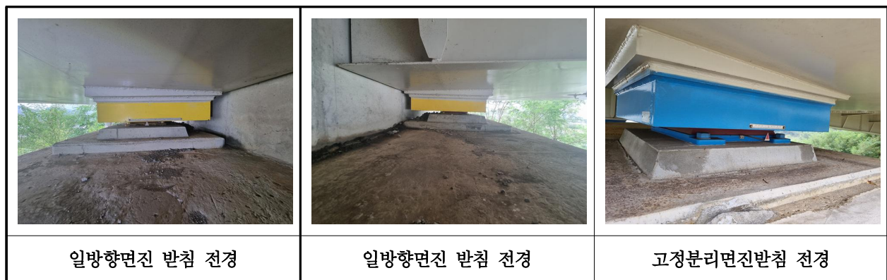
【사진 42.3.12】 교량받침 전경
