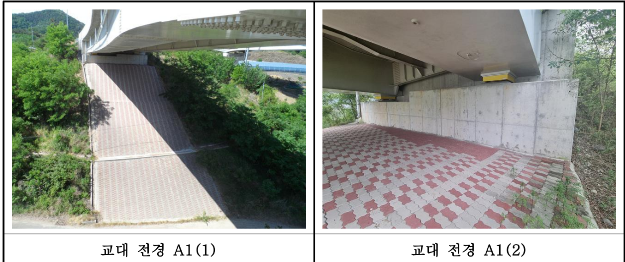
【사진 42.3.8】 교대 전경
