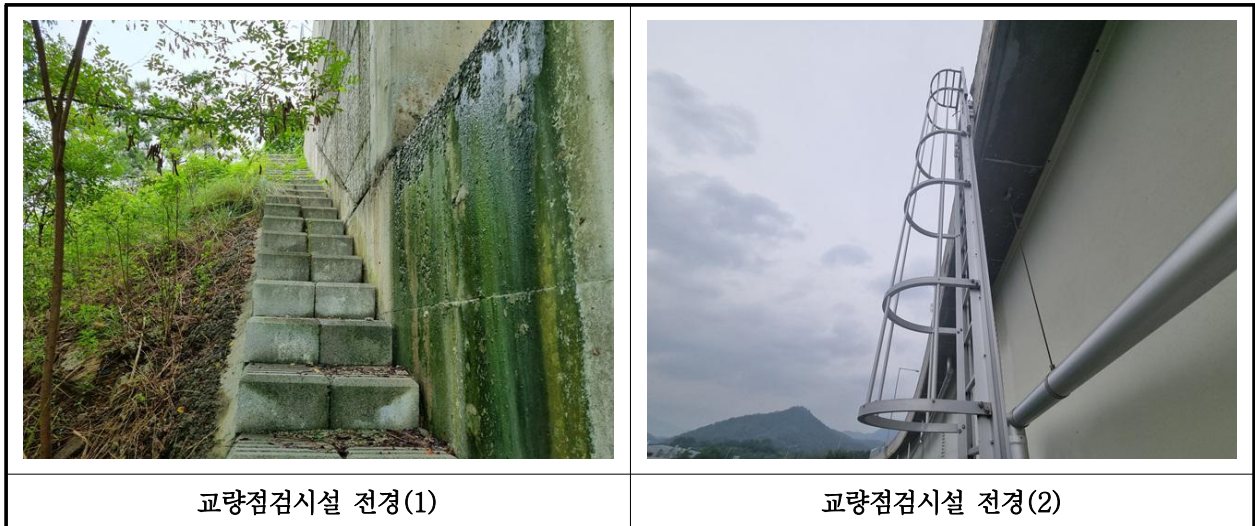
【사진 42.3.25】 교량 점검시설 전경
